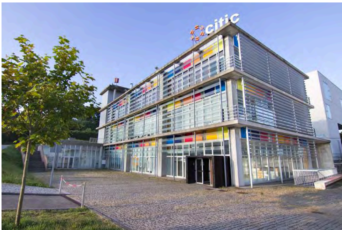
Edificio do CITIC na Coruña
