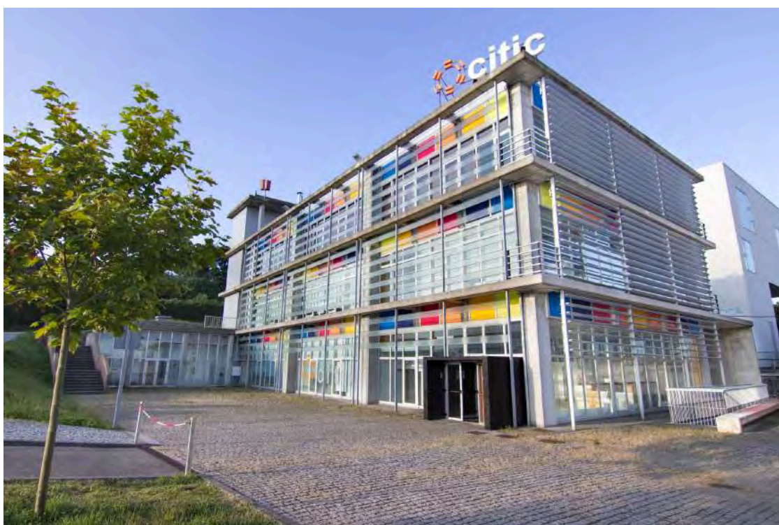
Edificio do CITIC na Coruña
