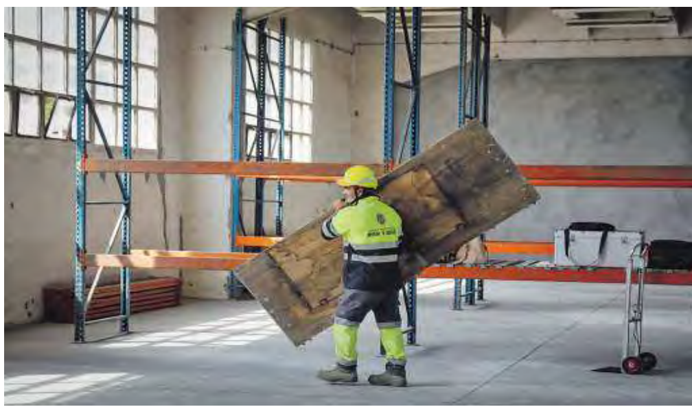
Un trabajador, en el inicio de la obra de construcción del CSA en Pedralonga en mayo del 2022. MARCOS MÍGUEZ
