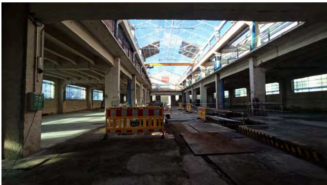
Las obras del Centro de Servizos Avanzados (CSA) en la Ciudad de las TIC de A Coruña.
