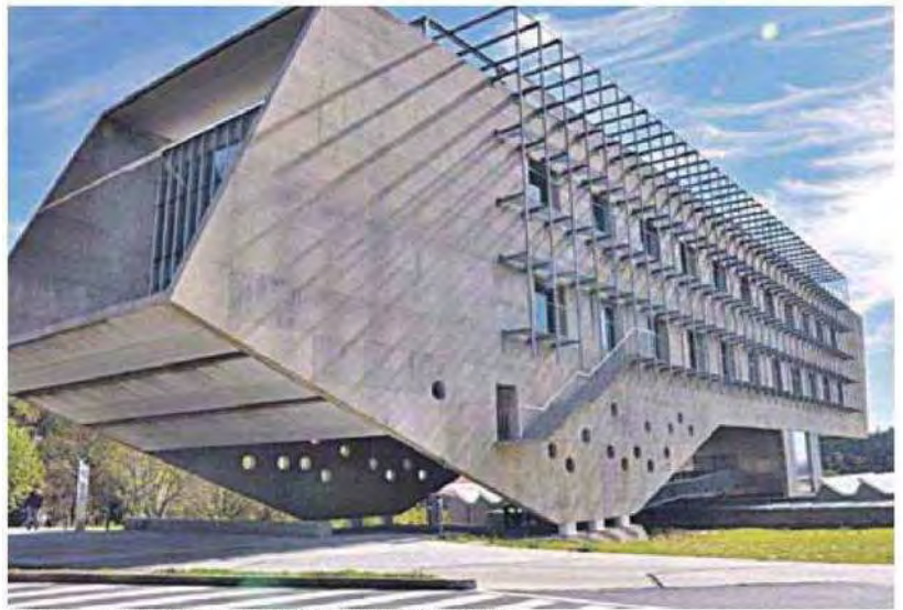
Centro de Investigación en Tecnologías, Energía y Procesos Industriales (CINTECX).
