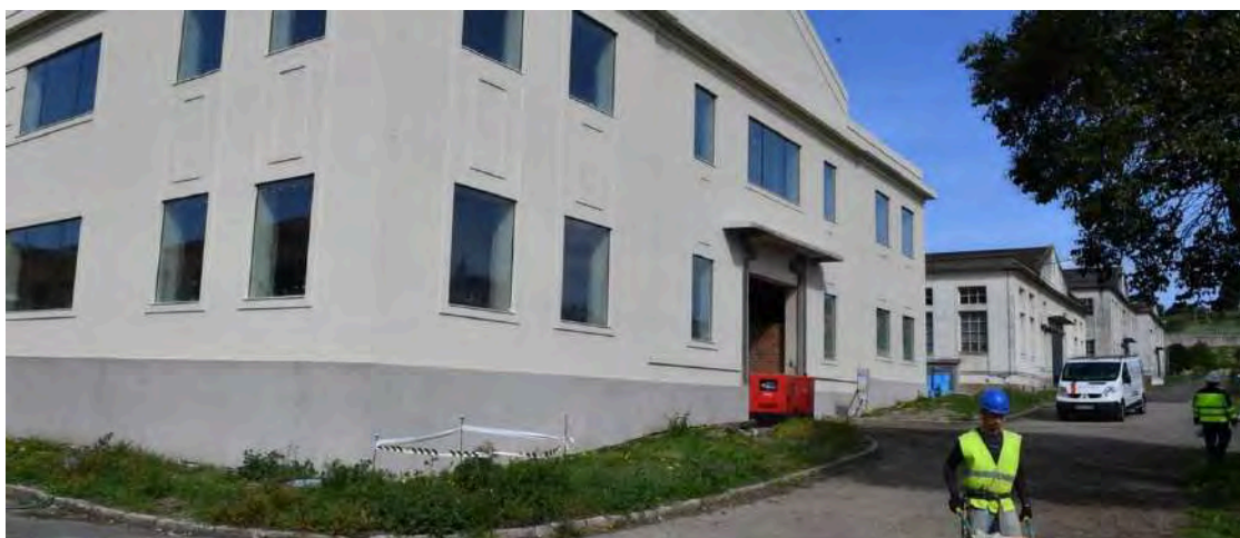
Obreros en la construcción del Centro de Servicios Avanzados de la Ciudad de las TIC. | // VÍCTOR ECHAVE
